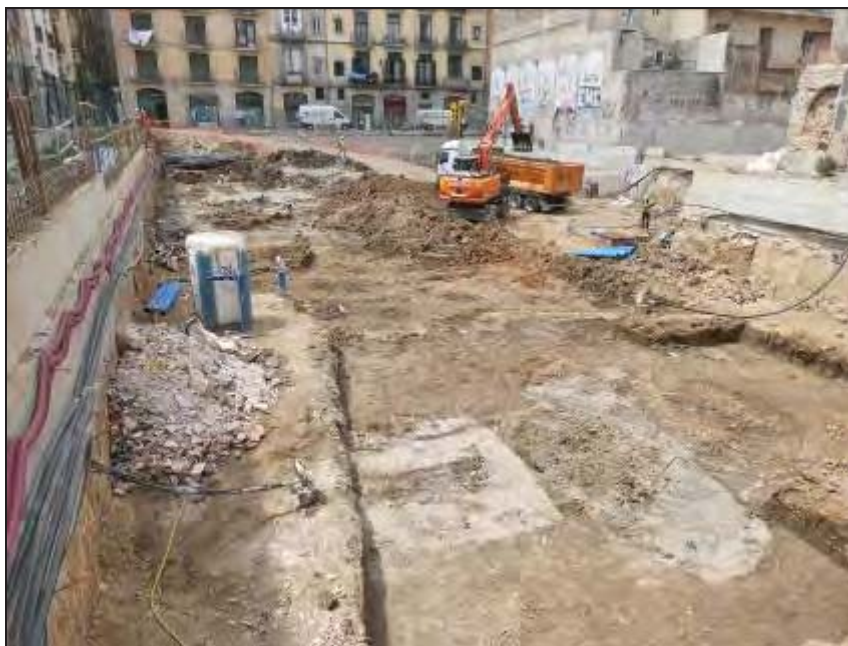
Treballs d'excavació entre la cota 1,60 i 0.70.
