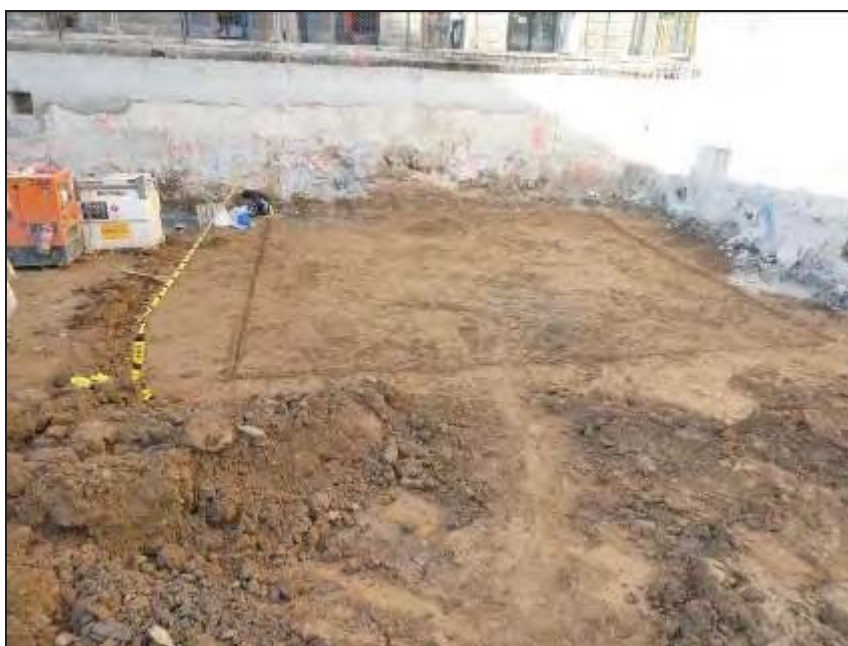
Sondeig 1. Sector nord-oest, al costat del carrer de Guàrdia
