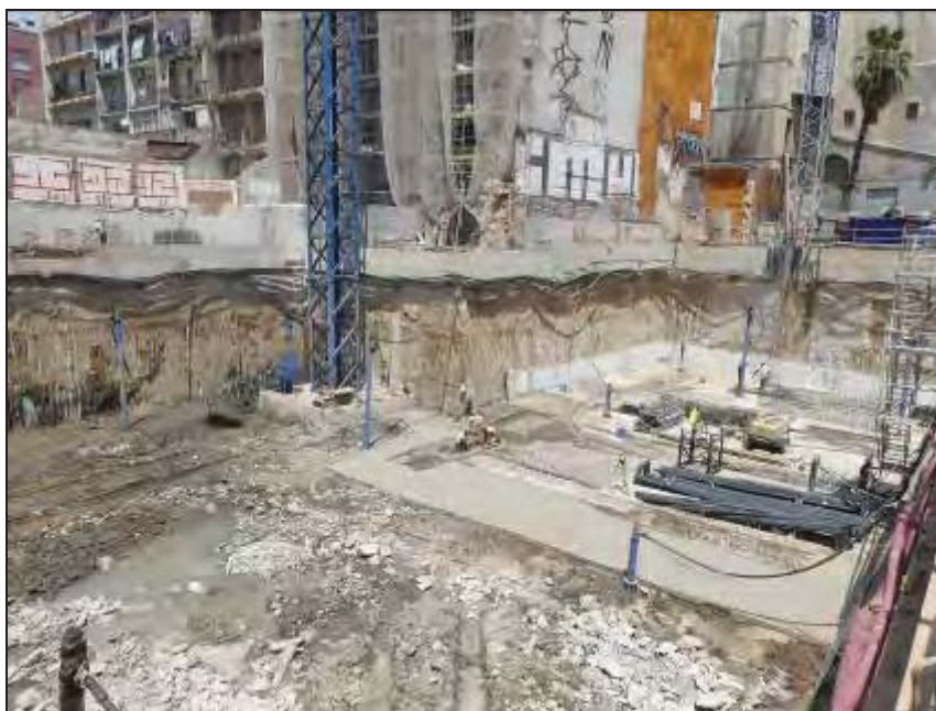
Fase final del rebaix.
