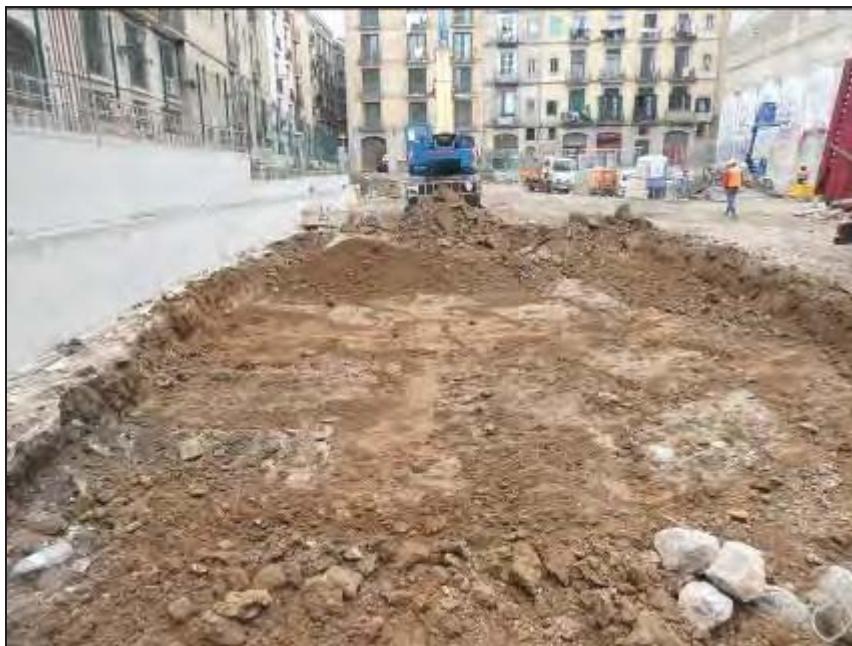
Inici dels treballs UE 7000.
