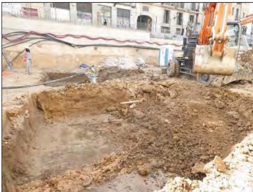
Darrer control del rebaix del solar.
